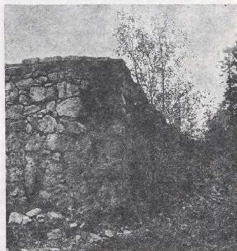
Sl. 95 Kalce — poškodovani vogal stolpa
