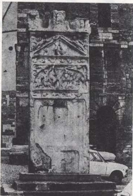
Sl. 73 Ptuj—Orfejev spomenik ponovno utrjen s silikonskim preparatom
