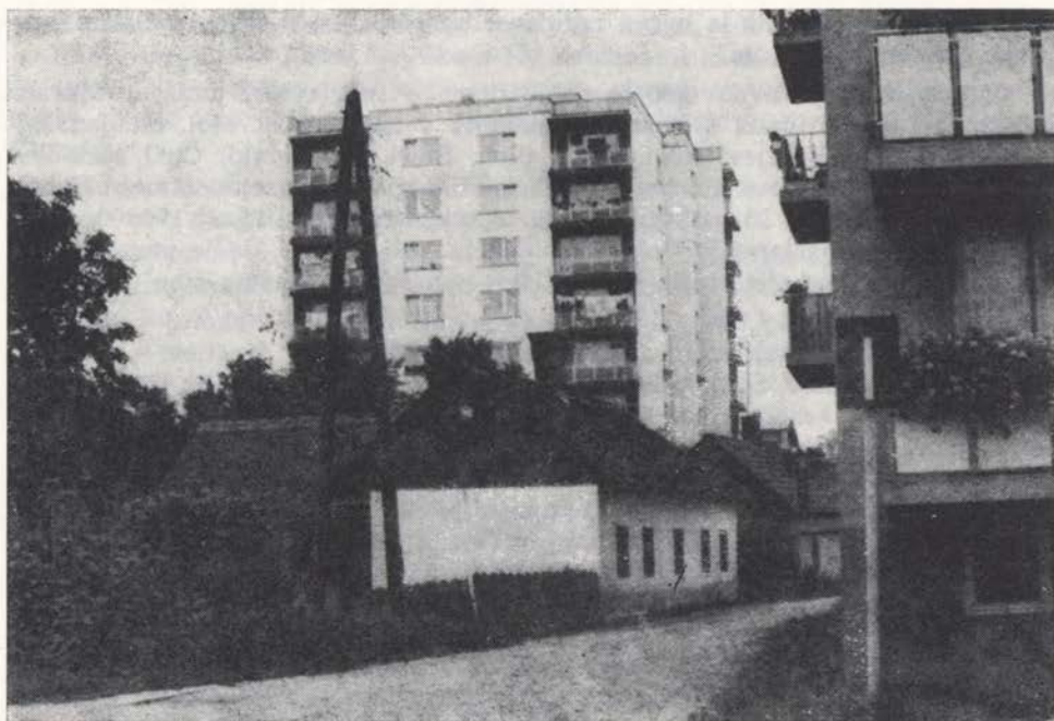
Sl. 71 Murska Sobota — Vrtna ulica
